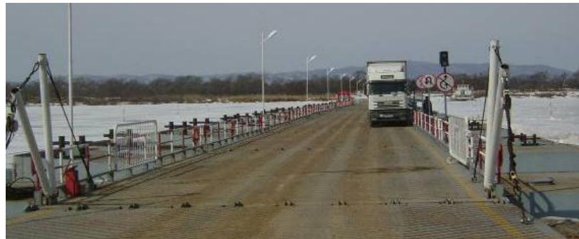
Рис. 7. Размещение испытательной нагрузки на комбинированной переправе при загрузке крайней балки
