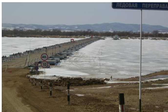
Рис. 1. Общий вид ледовой переправы, усиленной металлическими понтонными конструкциями
